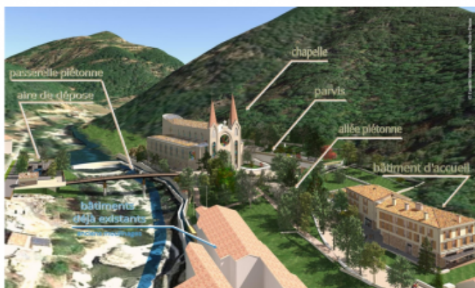
Un chantier deux tranches de travaux
