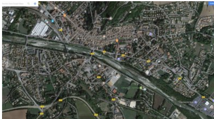
Crest : vue satellite autour du centre ville
