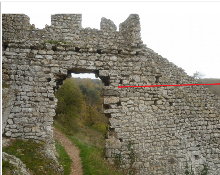
Porte haute, la maçonnerie se vide de son mortier
