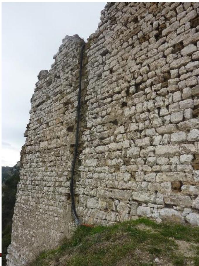
Au niveau du boîtier d'éclairage, une partie des câbles présents dans la gaine, sont apparents.
