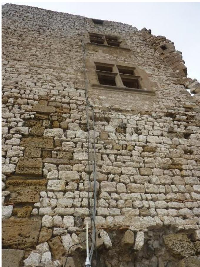
Plus au Sud, plusieurs gaines noires et câbles parcourent toute la hauteur de la façade Est du château. Ces câbles se poursuivent jusqu'au boîtier d'éclairage situé au pied de la façade.
